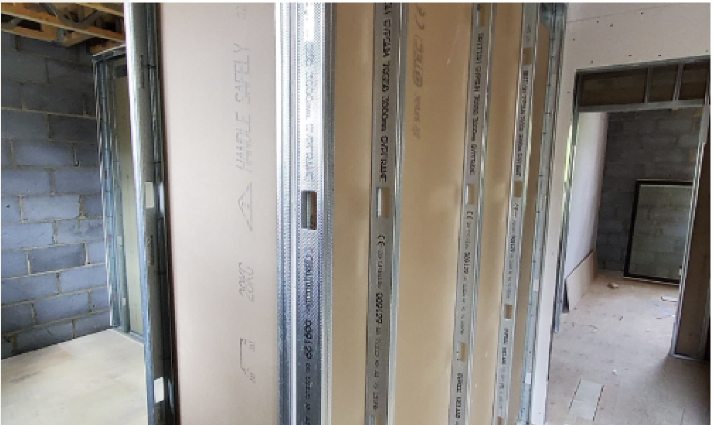
Metal Stud Partitioning
